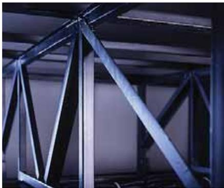
TRUSS SYSTEM WITH RUST INHIBITOR:
